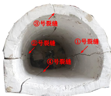
图 15 极限工况下的衬砌裂缝
